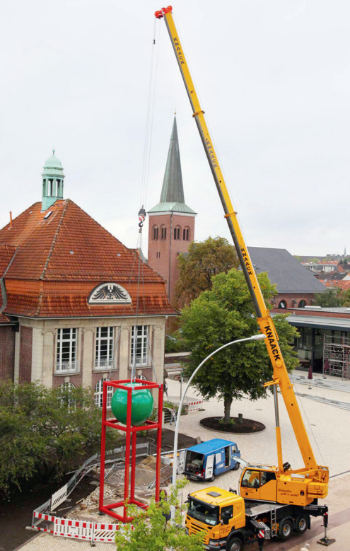
Kranarbeiten in Harburg
