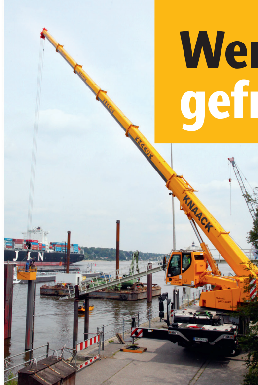
Kranarbeiten im Hamburger Hafen
