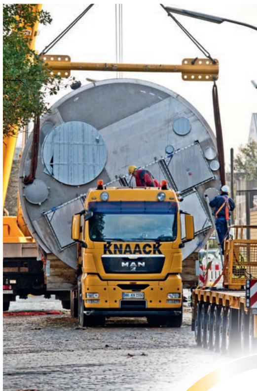
Transport eines Kessels
