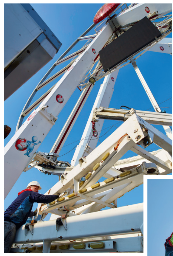
Arbeiter bauen das gut 60 Meter hohe Riesenrad (oben) sowie die Achterbahn „Spinning Racer“ (rechts) auf
