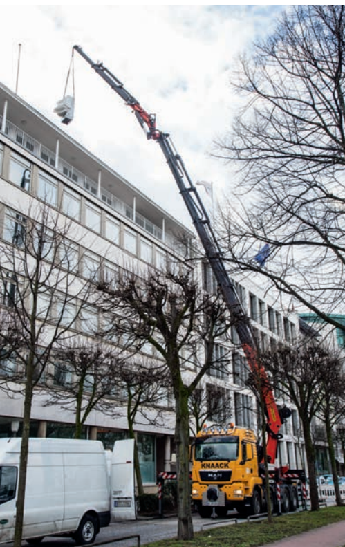
Kranarbeiten in Hamburg-St. Georg
